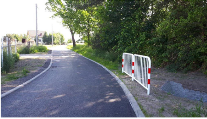
Przebudowa drogi gminnej ul. Polnej w Pilchowicach (inwestycja zakończona).
