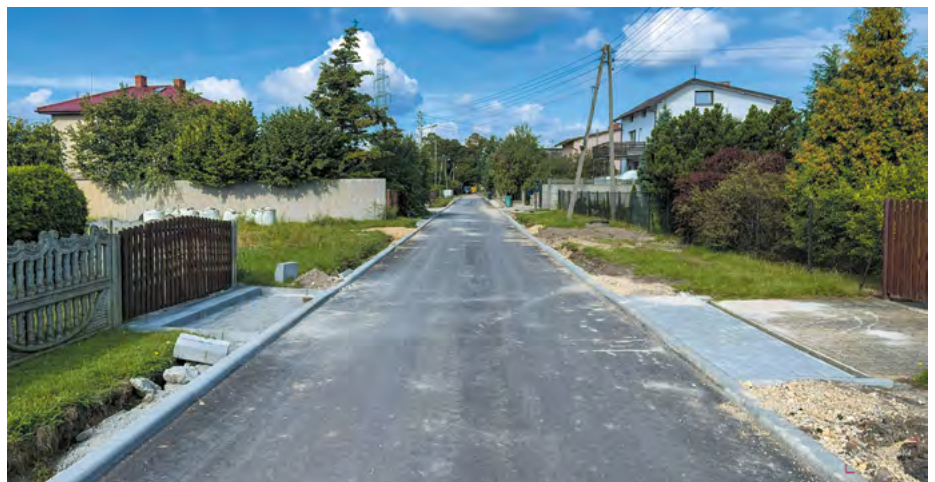
ul. Lipowa w Stanicy ma już nową nawierzchnię
