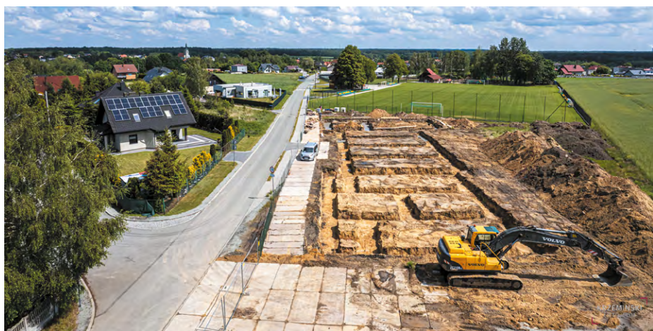
Budowa przedszkola przy ul. Sportowej w Stanicy
