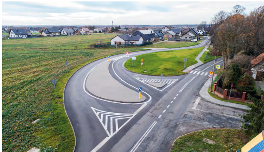
Przebudowa skrzyżowania ul. Olchowej, Szafranka i Gliwickiej w Żernicy – zadanie, które w 2019 roku wykonano w ramach inicjatywy samorządowej
