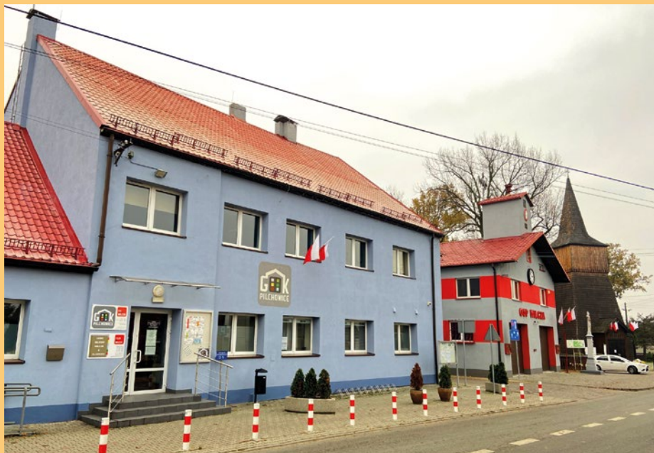
Wilcza - remont elewacji budynku Gminnego Ośrodka Kultury
