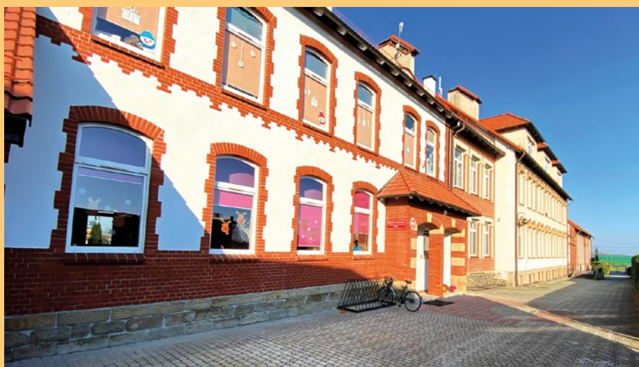
Wilcza - termomodernizacja Zespołu Szkolno-Przedszkolnego
