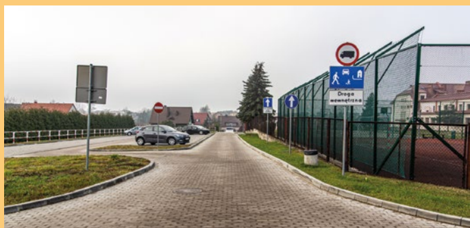
Żernica - budowa parkingu przy szkole - etap II
