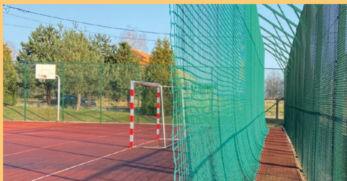
Żernica - remont ogrodzenia boiska wielofunkcyjnego
