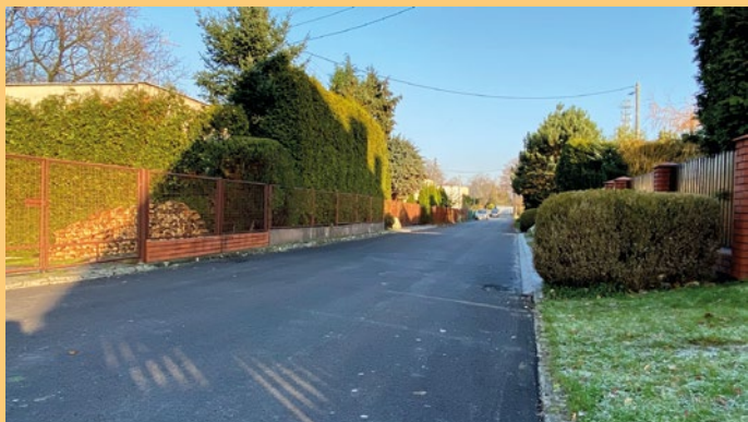
Żernica - remont ul. Słonecznej
