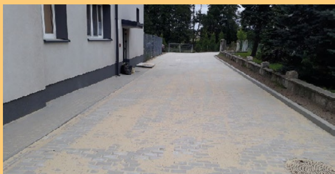
Stanica - budowa drogi pożarowej przy budynku ZSP Stanica
