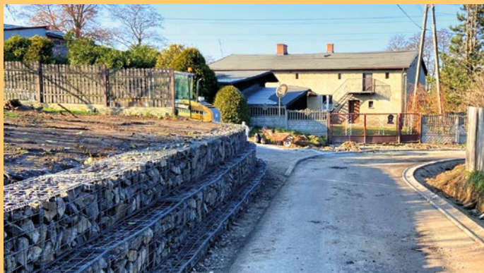
Wilcza - ul. Wysoka, przebudowa drogi gminnej
