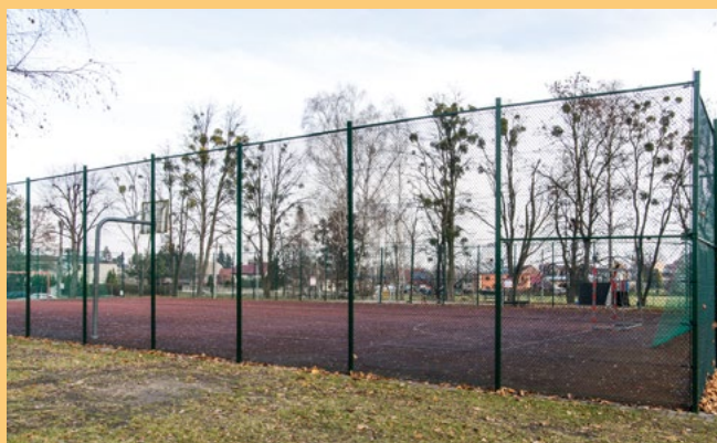
Pilchowice - remont ogrodzenia boiska przy szkole
