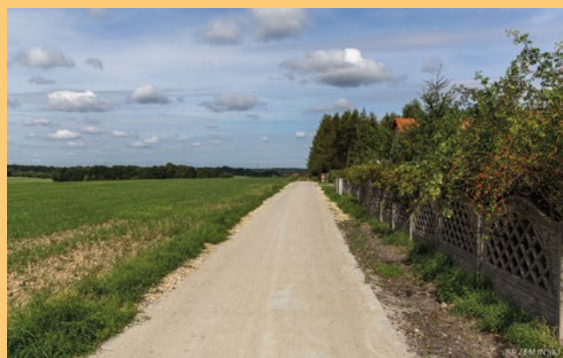
Pilchowice - utwardzenie drogi gminnej - ul. Rolników
