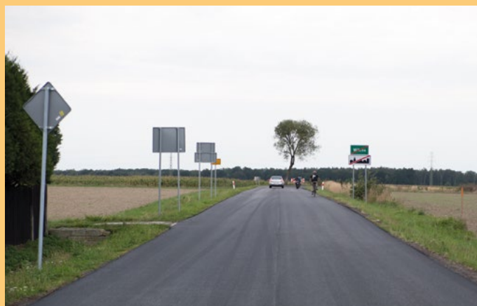
Wilcza - modernizacja drogi powiatowej - ul. Nieborowska (inwestycja Powiatu Gliwickiego z dofinansowaniem gminnym)
