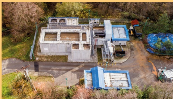
Żernica - rozbudowa oczyszczalni ścieków przy ul. Górniczej
