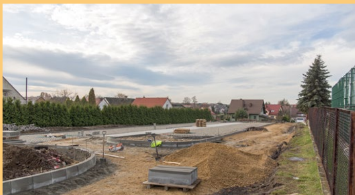
Żernica - budowa parkingu pomiędzy ul. Olchową i ul. Miki
