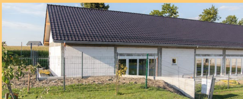
Żernica - rozbudowa przedszkola przy ul. Górniczej
