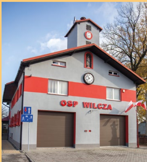
Wilcza - remont elewacji budynku OSP
