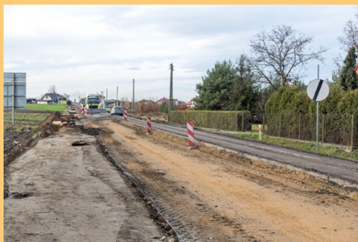
Pilchowice - budowa chodnika oraz przebudowa drogi wojewódzkiej nr 921
