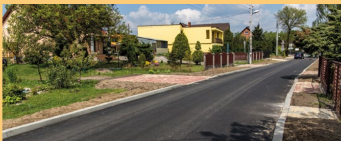
Pilchowice - przebudowa drogi powiatowej - ul. Leboszowska (inwestycja Powiatu Gliwickiego z dofinansowaniem gminnym)
