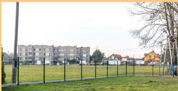
Żernica - budowa ogrodzenia boiska LKS „Naprzód”
