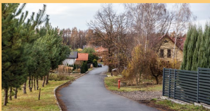
Nieborowice - remont dróg gminnych - ul. Sosnowa i Wierzbowa
