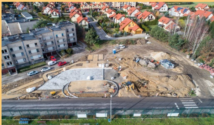
Żernica - budowa centrum przesiadkowego
