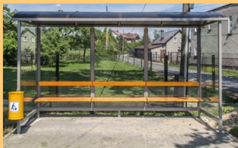
Nieborowice - zabudowa wiaty przystankowej przy ul. Krywałdz- kiej
