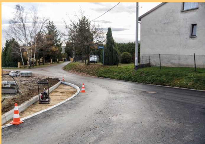
Żernica, ul. Brzozowa - przebudowa drogi gminnej
