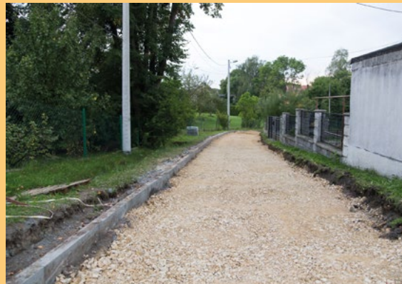
Pilchowice - ul. Sadowa w trakcie prac
