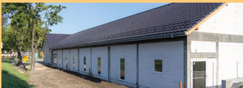
Żernica - nowe przedszkole już zadane i okna wstawione
