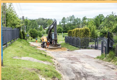
Przebudowa nawierzchni dróg gminnych: ul. Polna, ul. Zalesie w Nieborowicach po robotach kanalizacyjnych
