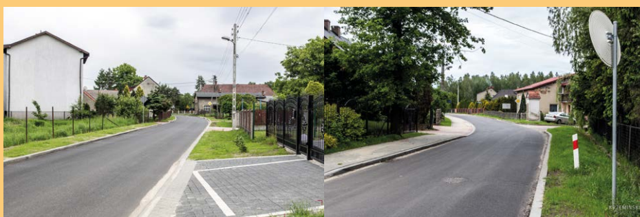
Budowa kanalizacji deszczowej dla ciągu pieszego wzdłuż drogi powiatowej w Pilchowicach (ul. Leboszowska) etap III. Inwestycja Powiatu współfinansowana przez Gminę.
