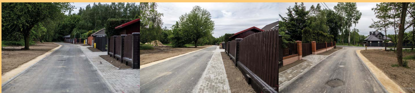
ul. Kamienna w Żernicy - budowa kanalizacji sanitarnej i droga
