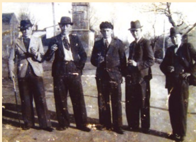
ul. Dolna Wieś, w tle transformator, ze zbiorów pana Józefa Nierychło
